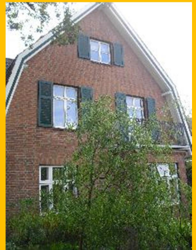
Das Mehrgenerationenhaus OASE mit unserer Tagespflegeeinrichtung im 1. Stock
